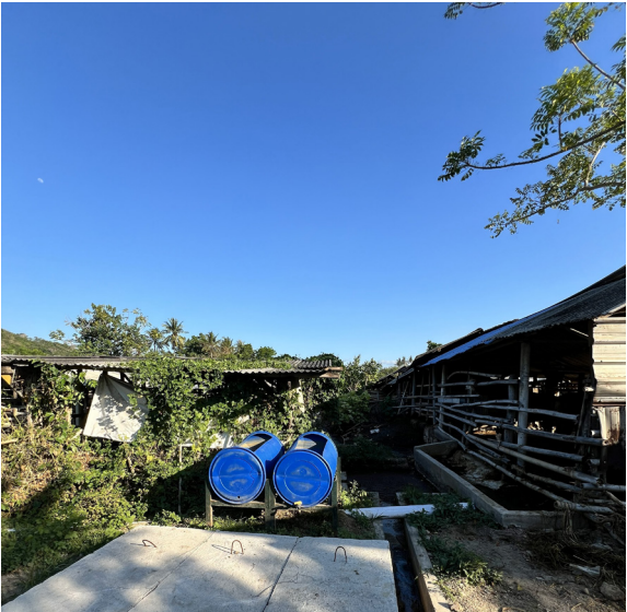
Fasilitas biogas komunal di Desa Taman Ayu yang mengolah limbah ternak menjadi energi bersih untuk kebutuhan bersama. (Dok. WRI)
